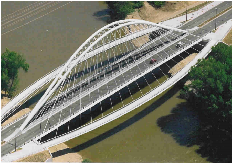
PUENTE SOBRE EL RIO EBRO (LOGROÑO). 140 M. DE LUZ BRIDGE OVER THE EBRO RIVER (LOGROÑO). SPAN LENGTH 140 M.
